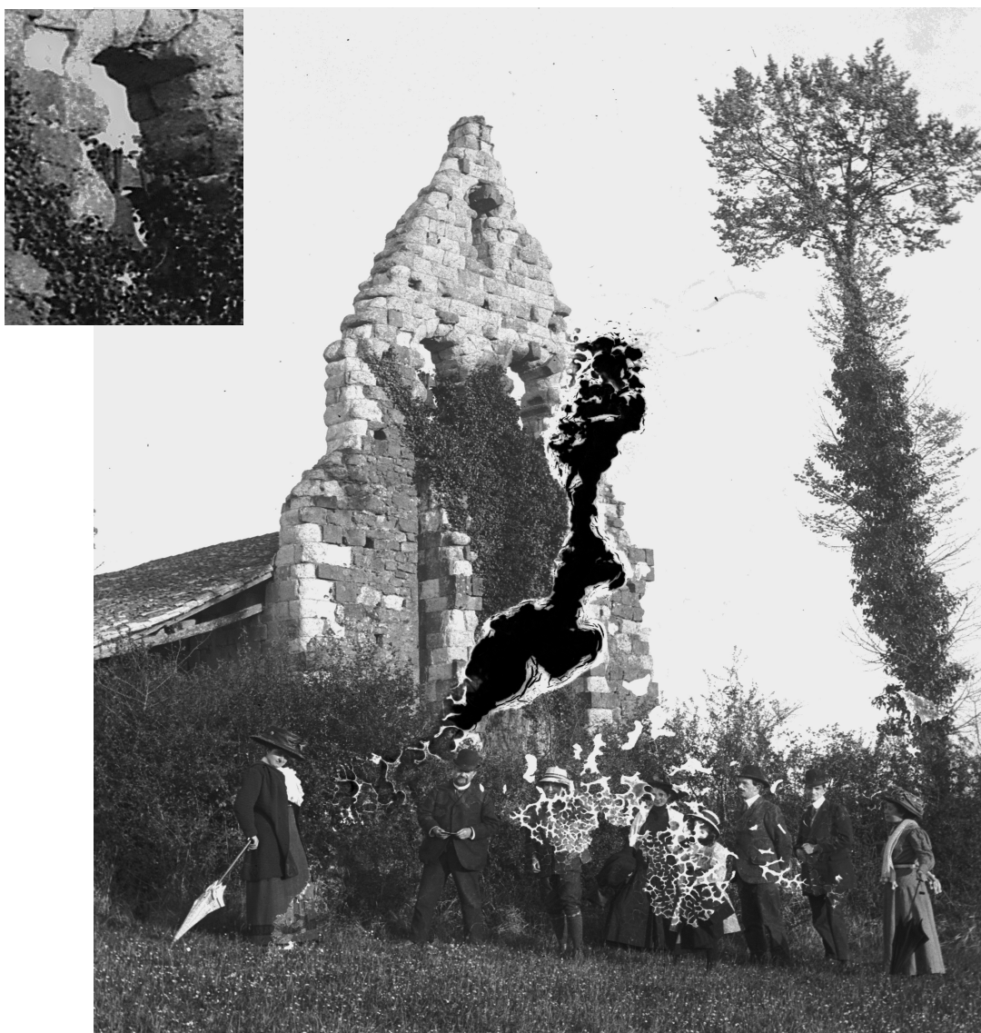
L'église de Briolet vers 1910 (Cliché Rodriguez). La zone noire est un défaut de gélatine). On distingue la cloche, la toiture et l'auvent encore existants, et l'état d'abandon du lieu.
